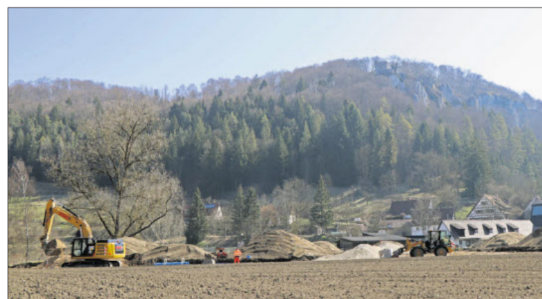
Die Erschließung des Neubaugebiets »Burgblick« in Gundelfingen hat begonnen. Auch das Feuerwehrgerätehaus soll hier entstehen. FOTO: BLOCHING
